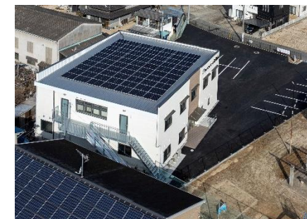
太陽光発電・蓄電池設置
